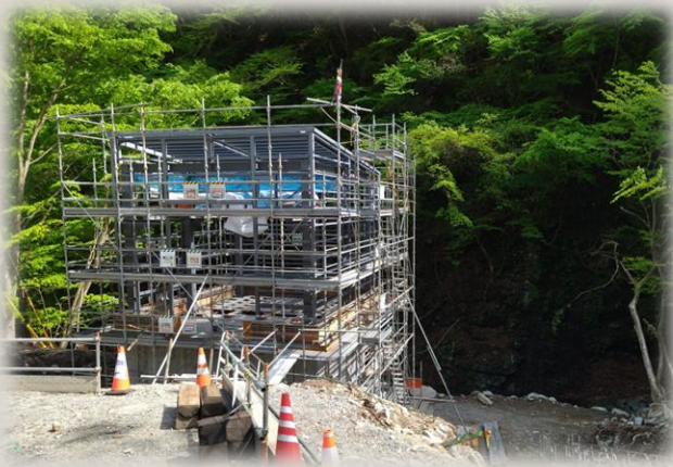
大月町真木に建設中の小水力発電所
